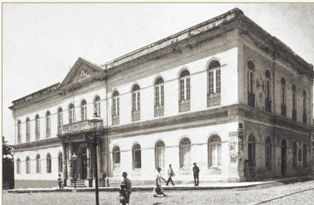
Prédio da antiga Assembleia Provincial, foto de 1912. Arquivo Nirez.
