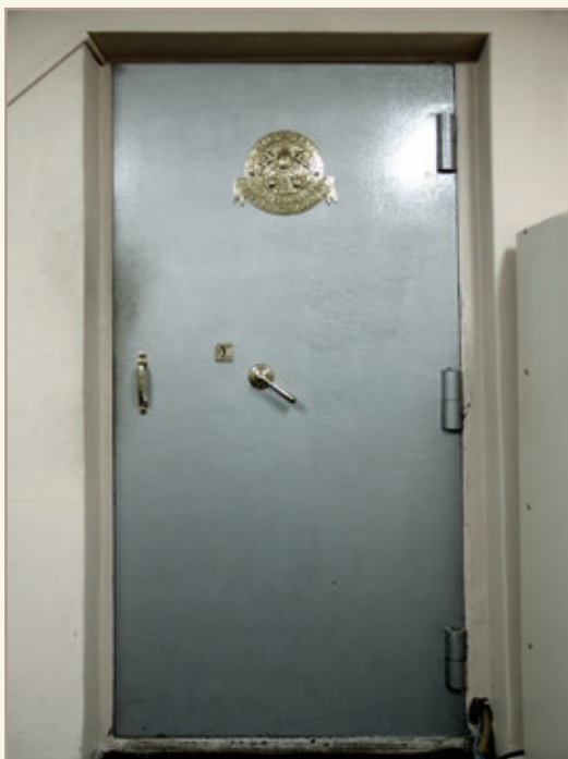
Sala do Cofre Forte, localizado na Sede I. Era utilizada para guarda do dinheiro coletado. A sala mede 3,77 x 3,40, com paredes de 60 cm de espessura. A porta de aço da sala mede 1,80 de altura por 0,90 cm de comprimento, sendo sua espessura de 20 cm.
