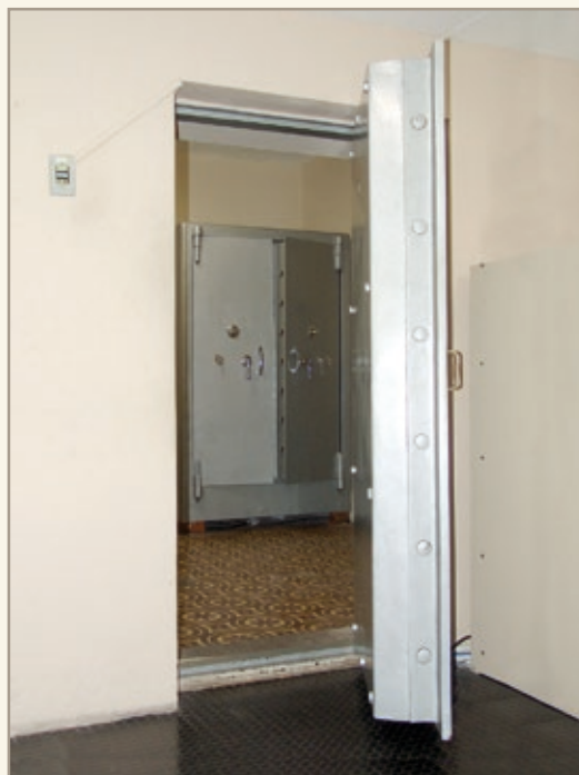
Sala do Cofre Forte, localizado na Sede I. Era utilizada para guarda do dinheiro coletado. A sala mede 3,77 x 3,40, com paredes de 60 cm de espessura. A porta de aço da sala mede 1,80 de altura por 0,90 cm de comprimento, sendo sua espessura de 20 cm.
