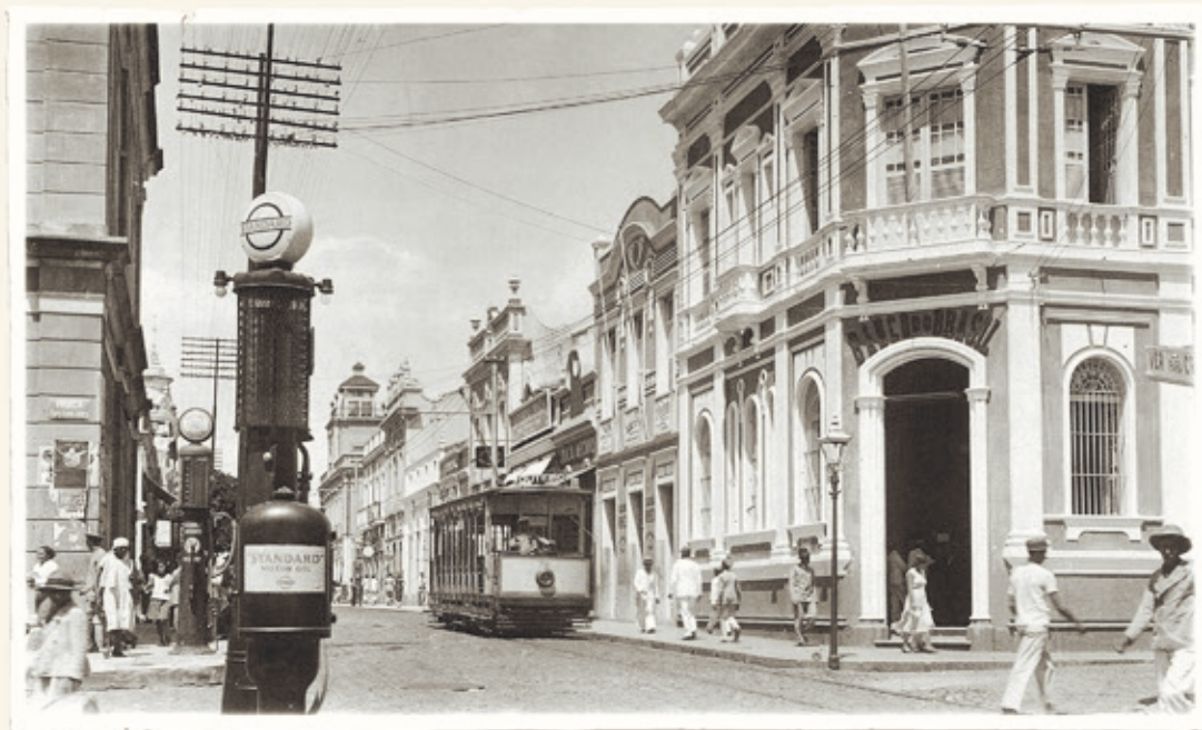
Bonde elétrico na Rua Floriano Peixoto esquina com a Rua São Paulo, 1935. Arquivo Nirez.
